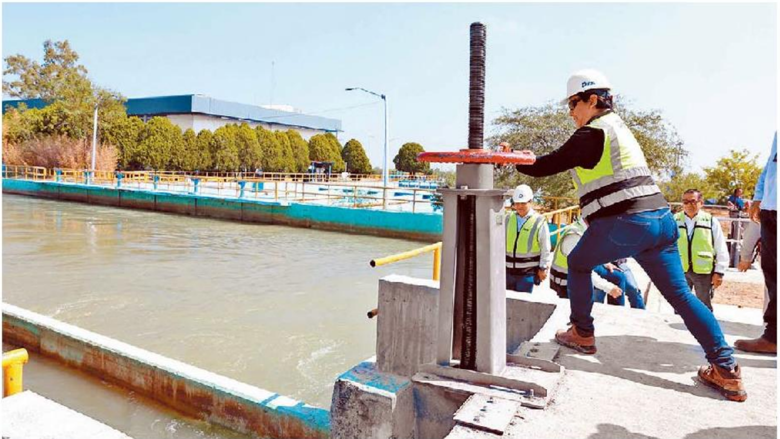
Acueducto El Cuchillo II en Nuevo León, última obra inaugurada por el gobierno. RAÚL PALACIOS
