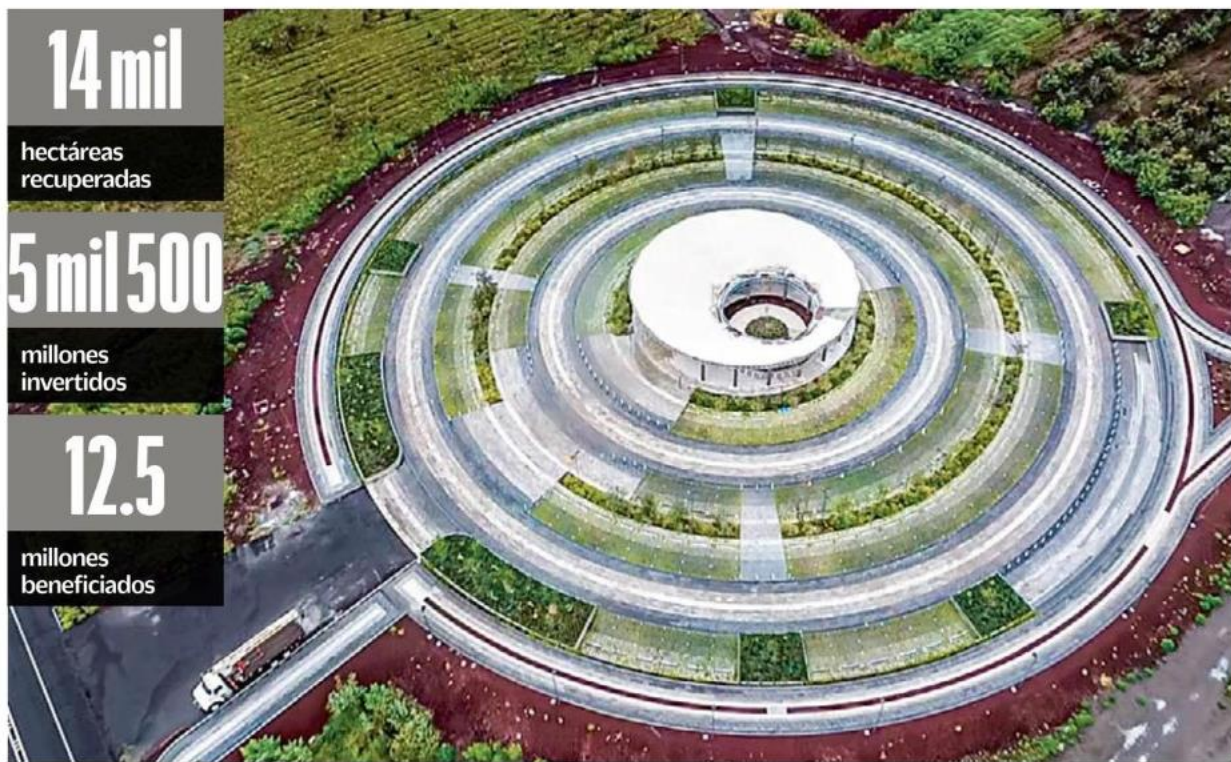
PROYECTO. El Parque Ecológico Lago de Texcoco enlista una de las 18 obras prioritarias de la Conagua, con una inversión de alrededor de 5 mil 500 millones de pesos.
