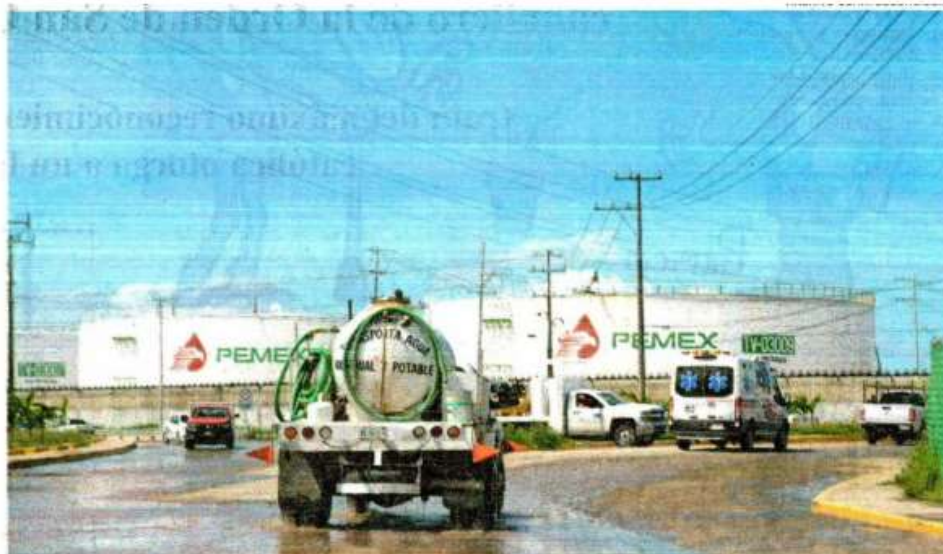
La refinería Olmeca en Dos Bocas, Tabasco reportó inconsistencias en algunos pagos y contratos, indicó la ASF
