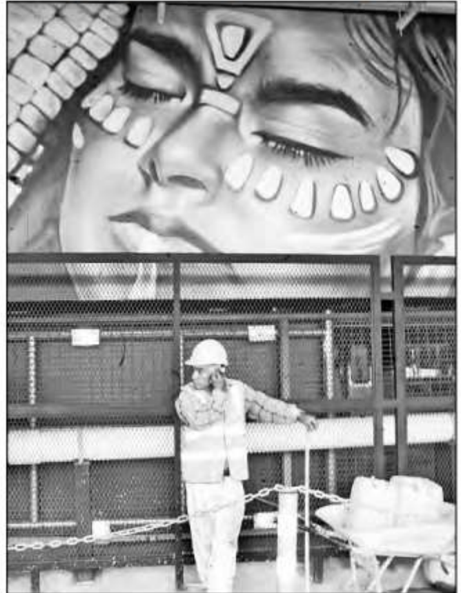
▲ Trabajos de mantenimiento en la estación Indios Verdes del Metrobús. Foto Roberto García Rivas
