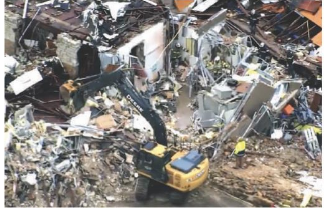
CON APOYO de maquinaria, personal de emergencias busca a sobrevivientes entre los escombros.
