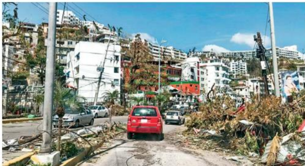
RUINAS. El huracán destruyó todo lo que estaba a su paso, en Pie de la Cuesta muchas familias quedaron sin hogar y aún hay un importante número de desaparecidos.
