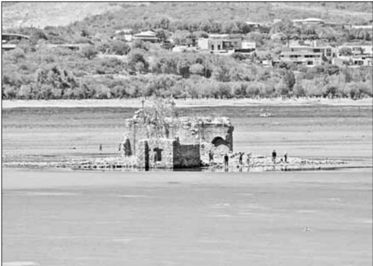
▲ La estructura de una ex hacienda que estaba bajo el agua salió a la superficie por la falta de líquido en el embalse, y ahora es un atractivo turístico de la ciudad de León. Foto Cuartoscuro
