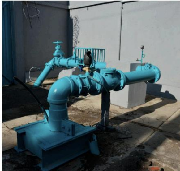
Durante las obras, el GCMX apoyó a vecinos con mil 96 pipas.
