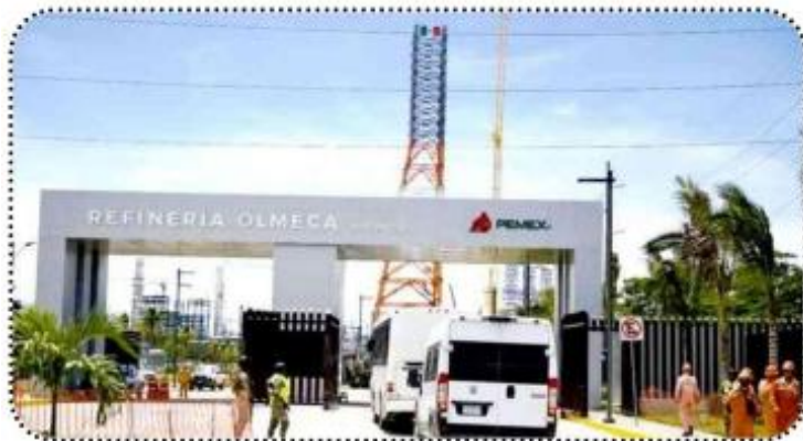
Refinería de Dos Bocas
