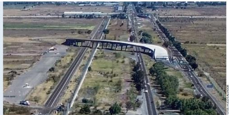
DIVIDIDO. Al parque lo parte en dos la autopista Peñón-Atlixco, que cuenta con un puente inconcluso.
