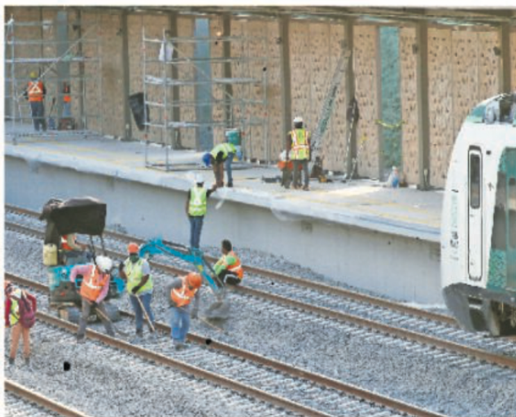
Aunque el Tren Maya no se ha concluido, el Proyecto de Presupuesto de Egresos no destina recursos a esa obra.
