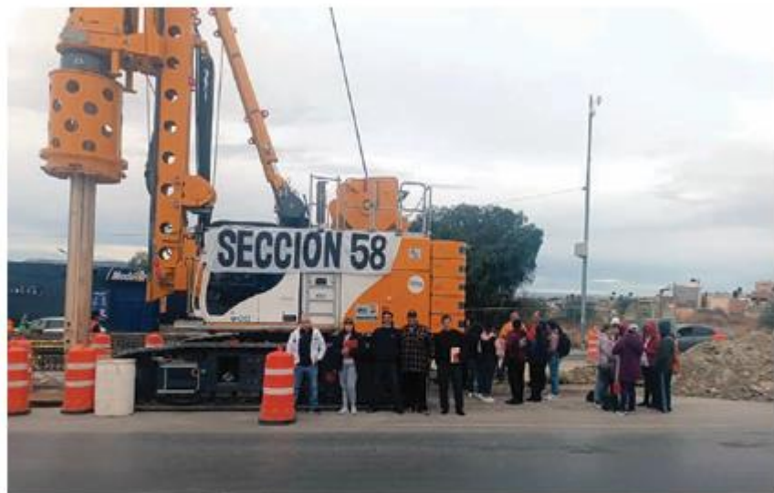
INTEGRANTES de la Sección 58 del SNTE, al tomar el sitio en donde se construye el Viaducto Elevado de Zacatecas, el pasado 21 de febrero.
