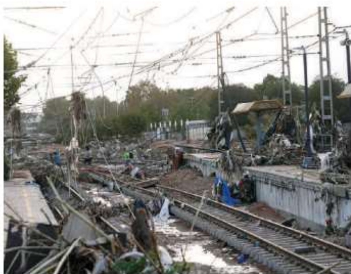
TRENES Y OTROS TRANSPORTES se vieron obligados a suspender el servicio ante los evidentes daños a la infraestructura.
