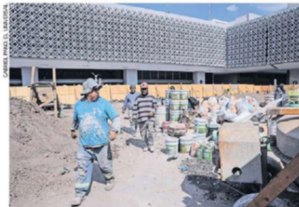
Por quinta ocasión se realizan trabajos de impermeabilización y cambio de piso en la explanada, debido a filtraciones.
