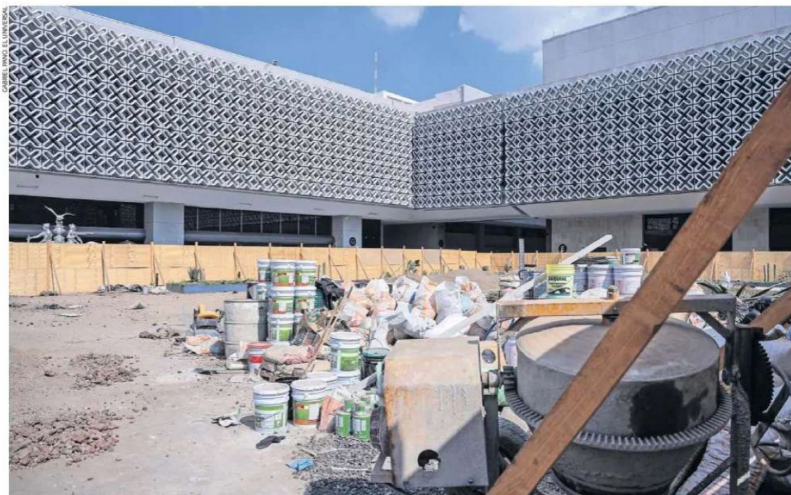
Cerca de 40 millones se utilizaron, entre otras obras, para sustituir pisos en la explanada a fin de evitar filtraciones.
