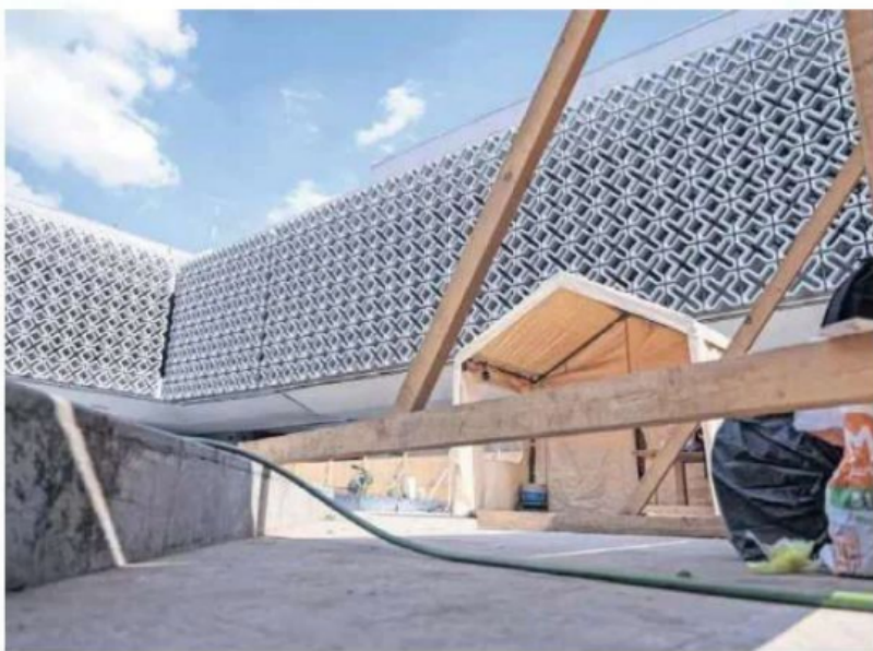
En 2023 se proyectaron diversos trabajos de rehabilitación y construcción de nuevos edificios que aún no han concluido. Se prevé que terminen este año, según autoridades de la Cámara.
