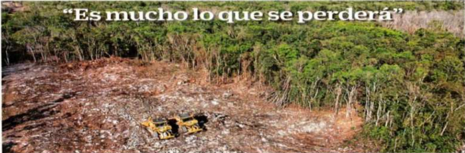
SEGUNDA ENTREGA. El ruido de las máquinas se combina con el aroma de árboles recién cortados en el nuevo trazo del Tren Maya, donde los trabajos avanzan, pese a que no se han entregado los permisos para la obra. Ambientalistas alertan sobre la deforestación. | ESTADOS | A14
