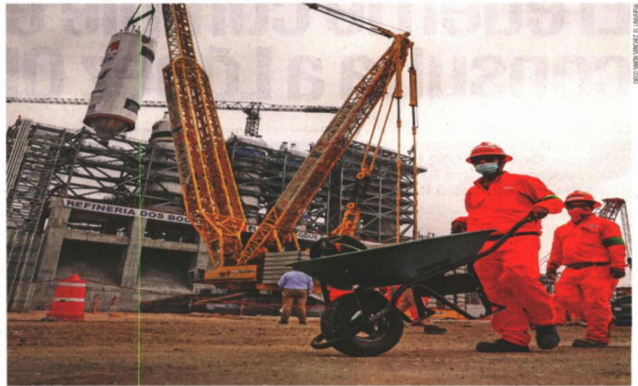
En el complejo operan más de 32 mil trabajadores para concluir la refinería Olmeca antes de su inauguración, el próximo 2 de julio. El avance en la construcción hasta ahora es de 90%.
