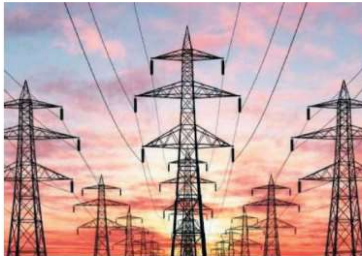
El primer mandatario aseveró que se buscará la protección de la CFE. Especial
