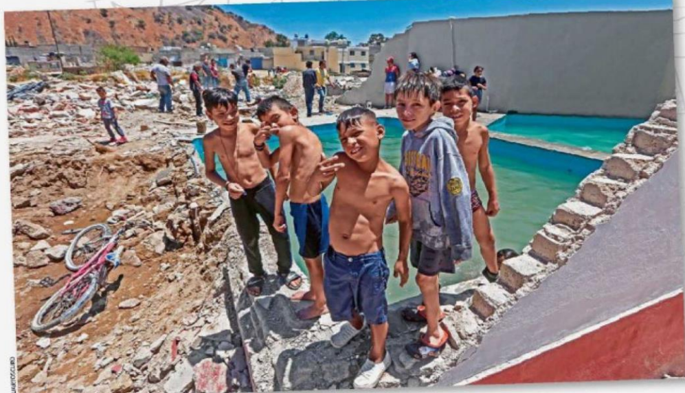
CHAPUZÓN IMPROVISADO. Niños aprovechan que la alberca de una finca derribada quedó al aire libre para refrescarse. Las casas de la colonia Miramar, en Zapopan, Jalisco, fueron demolidas por el riesgo de inundaciones.
