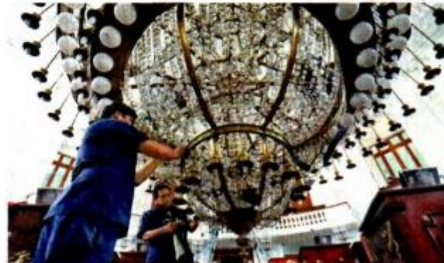
Al candil le hacen dos tipos de mantenimiento; el corto consiste en limpiar los focos y el largo en quitarlos y pulirlos. Este dura 15 días.
