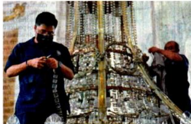
Algunos focos han sido sustituidos por otros que hagan armonía con el tono de luz; los sockets latonados son los más difíciles de conseguir.
