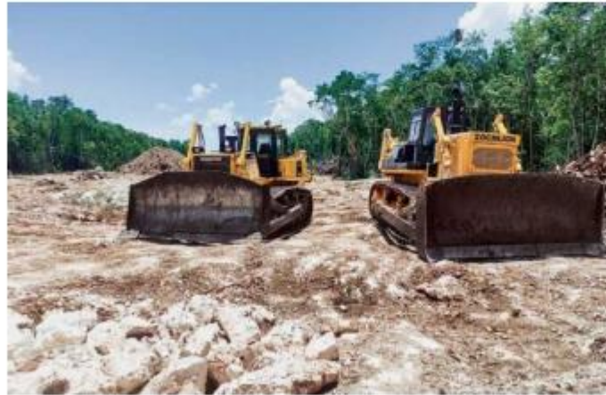
PROYECTO. En el Tramo 5 del Tren Maya, ya se observan a trabajadores; esta zona ha sido una de las más polémicas durante la construcción de dicha obra.
