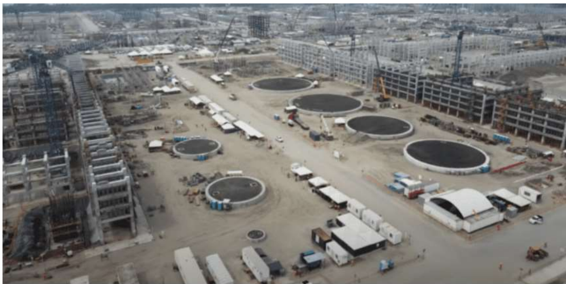
Construcción de la refinería de Dos Bocas, Paraíso, Tabasco
