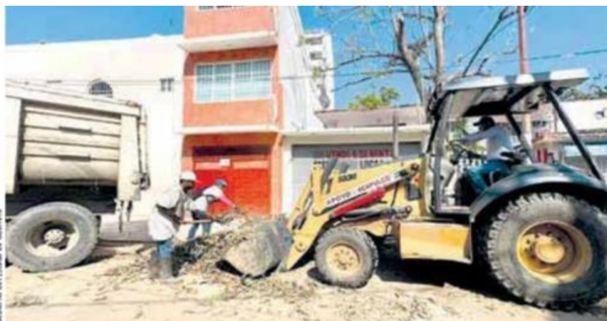
Apoys para la rehabilitación de viviendas.
