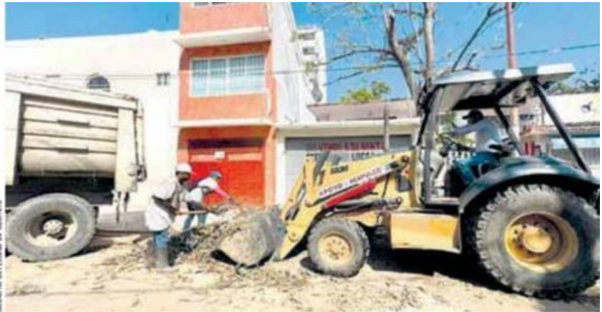
Apoys para la rehabilitación de viviendas.
