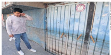
Néstor y su familia abandonaron desde agosto su casa, ubicada en el punto más afectado por la inundación.
