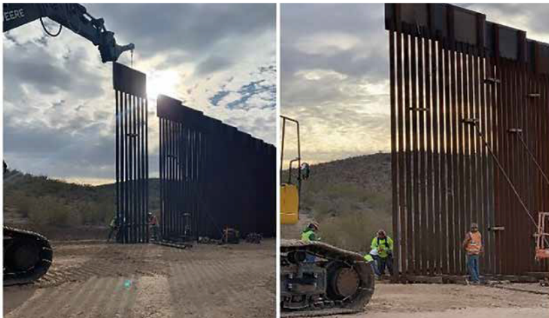
El jefe de la Patrulla Fronteriza, Michael Banks, publicó en X fotografías que muestran la construcción del muro, en los espacios que quedan a lo largo de la frontera cerca de Deming, Nuevo México. (Fotos: Redes Sociales) ▶ 17
