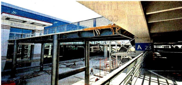
CUENTA REGRESIVA. El nuevo aeropuerto será inaugurado el 21 de marzo. Estiman que en el primer año tendrá 60 operaciones diarias.
