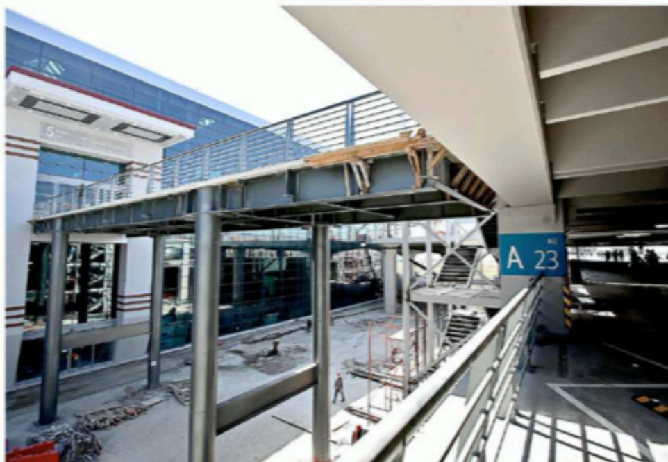
CUENTA REGRESIVA. El nuevo aeropuerto será inaugurado el 21 de marzo. Estiman que en el primer año tendrá 60 operaciones diarias.
