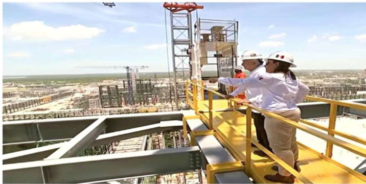
El Presidente López Obrador hizo un recorrido por las instalaciones de la refinera.
