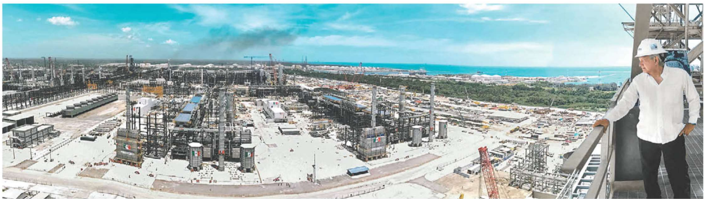
El Presidente subió a una torre de la planta de Pemex en Tabasco para supervisar los avances. ESPECIAL
