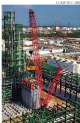
Vista de los avances de la refinería en Dos Bocas, inaugurada ayer.
