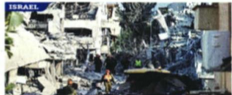
Un misil disparado desde Irán impactó al sur de Tel Aviv, provocando graves daños en inmuebles.
