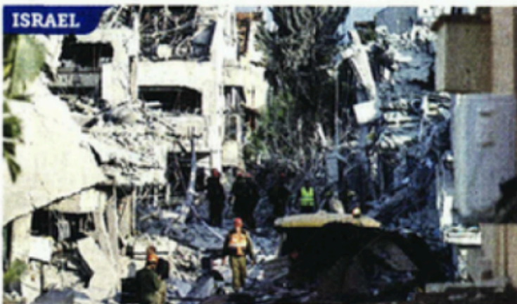
■ Un misil disparado desde Irán impactó al sur de Tel Aviv, provocando graves daños en inmuebles.
