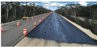
Trabajos en la vía Izamal-Cancún.
