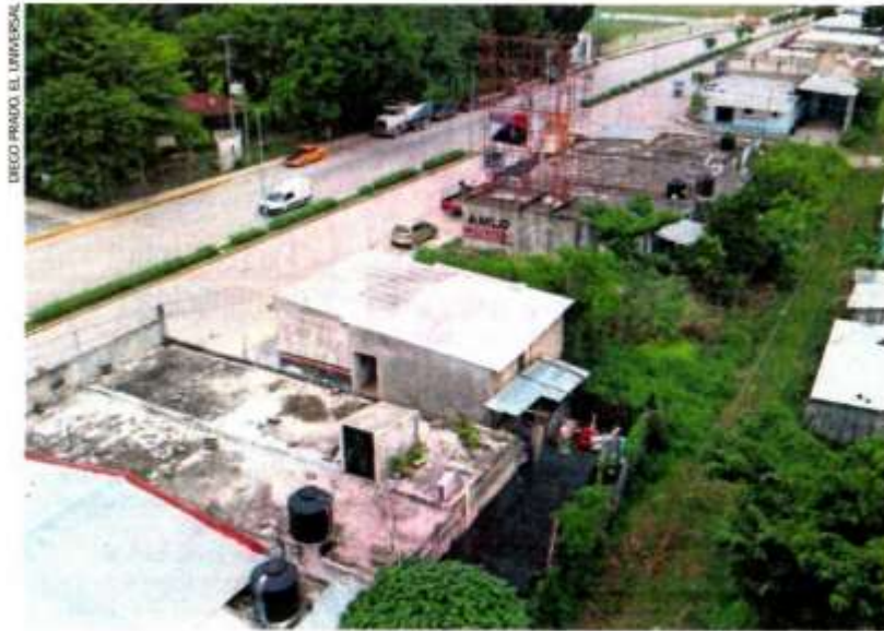
Todos los edificios, como estos en Candelaria (Campeche), a 20 metros a cada lado de las vías tendrán que ser demolidos ya que por seguridad el Tren Maya debe ir vallado.
