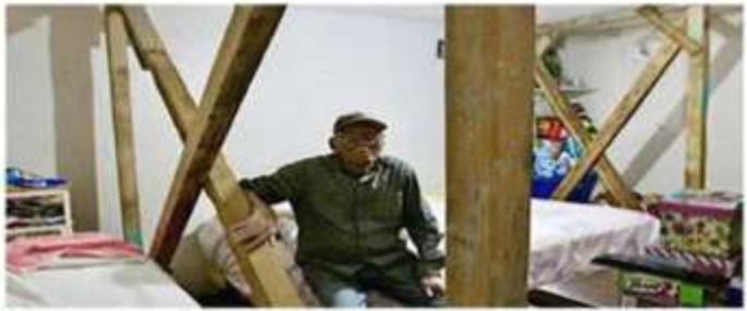
Desde hace años, vecinos hacen su vida entre las estructuras puestas para evitar un derrumbe.
