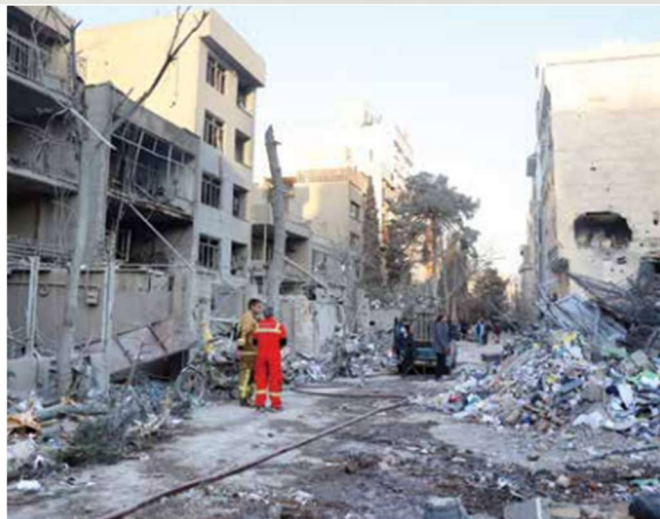
• TEHERÁN. Las ofensivas militares de la alianza EU-Israel ya provocaron fuertes daños estructurales en la capital de Irán.
