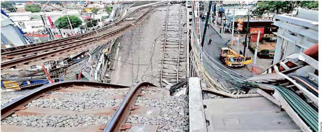
Una estructura retorcida, cables y vías suspendidas, así lucía ayer el tramo colapsado de la Línea 12 del Metro.
