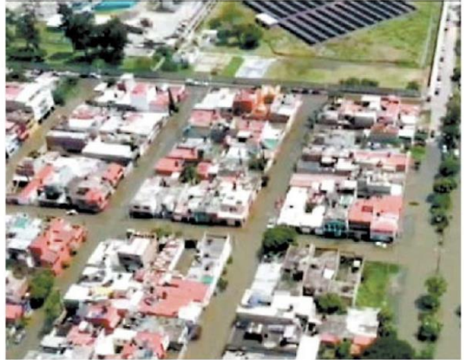
Desfogue ocasiona daños en 350 casas. ESPECIAL
