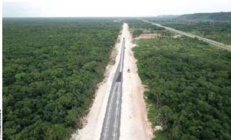
AVANCE en las obras del Tren Maya en Tenabo, Campeche, el pasado 1 de agosto.
