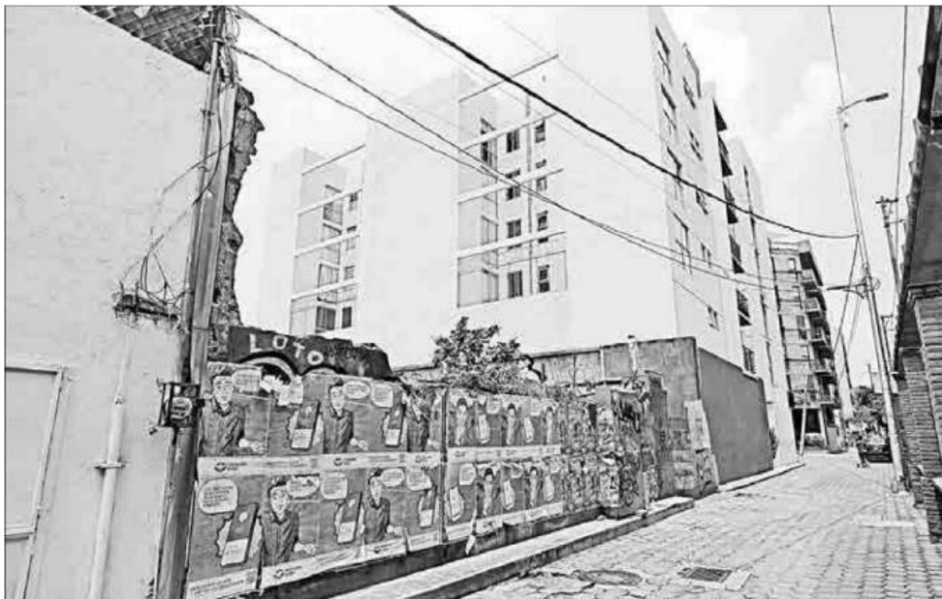
◀ La construcción de edificios en Benito Juárez aumentó de manera desmesurada en los gobiernos panistas. En esta imagen, sitio donde cayó el edificio de Zapata 56. Foto Luis Castillo
